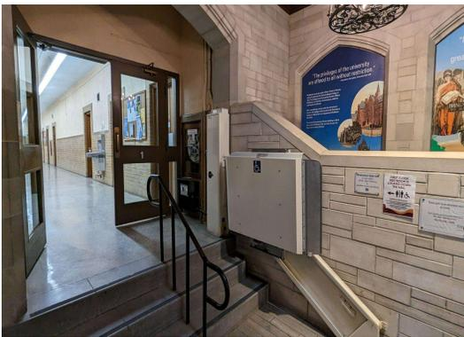
Figure 4.47 Plate-forme élévatrice au bout du couloir au premier étage du University Hall
