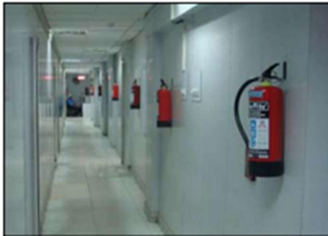
Figure 3.24 Extincteur installé dans les zones de circulation générale, Janpath Bhawan, New Delhi, Inde [102]
