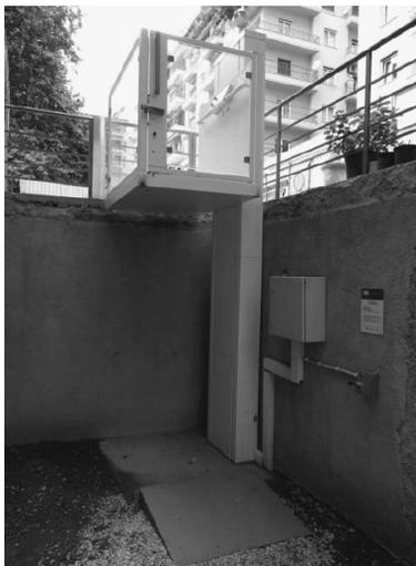
Figure 3.13 Ascenseur installé à Acheiropoiitos, Grèce [93]
