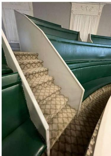
Figure 4.17 Marches raides dans la galerie de Province House avec des mains courantes inadéquates et des sièges étroits
