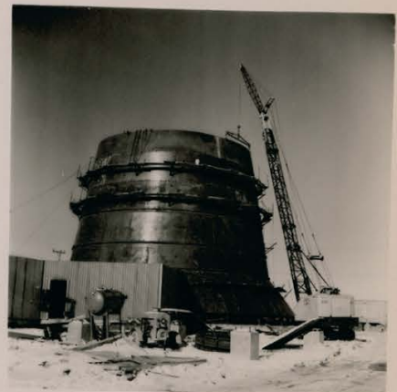
Fig. 10-34 Atlas Silo LN 1-1-71
