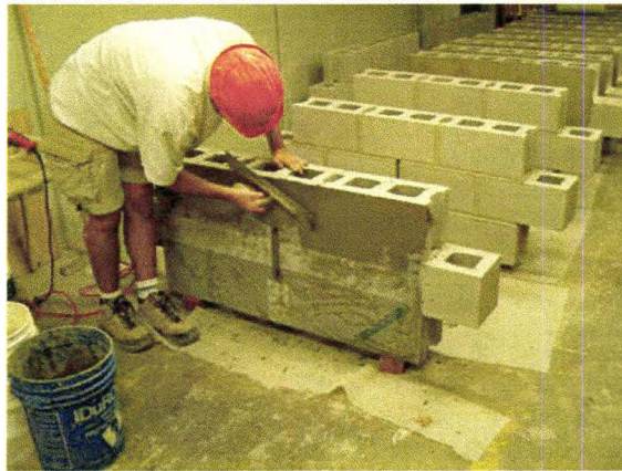
(d) Applying a Layer of Parging Over the Mesh
